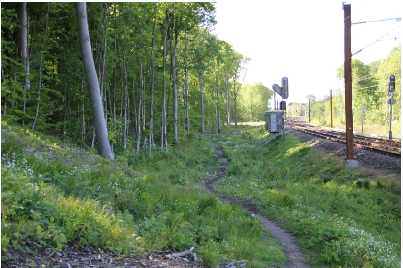
Figur 21: I forbindelse med elektrificeringen af jernbanen er skovbrynet ud mod denne trukket tilbage på begge sider, efterladende en lysåben bræmme. Her litra 2h til venstre og litra 1c og f på jernbanens modsatte side.
